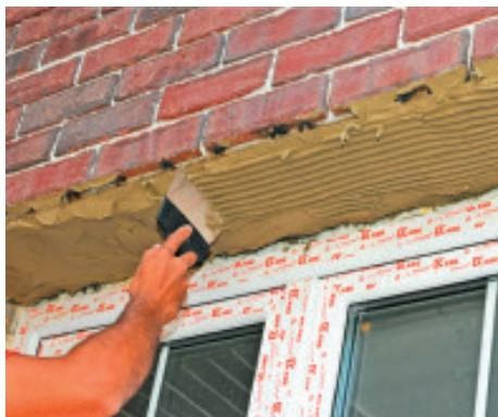
1. Очистіть несучу поверхню від будівельного розчину. Нанесіть ґрунтовку для фасадних робіт.
