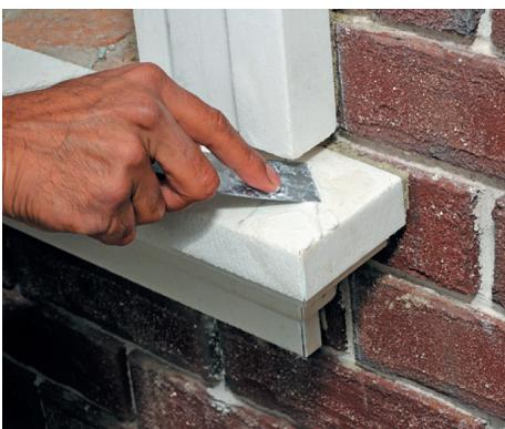
16. Покрайте місця стиків сумішшю "DarMix" шпателем на глибину 2-2,5 мм.
