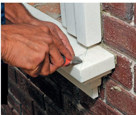
15. Розділіть всі з'єднуючі шви, звільнивши 2 мм у ширину та глибину від верхнього краю поверхні для нанесення суміші "DarMix".
